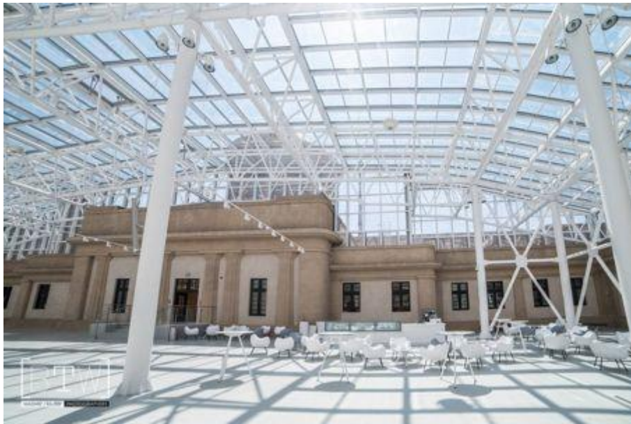
Fot. 24 Wnętrze Pawilonu Czterech Kopuł obecnie
