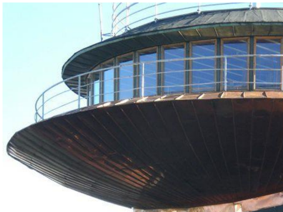
Fot. 41 Poszycie dachowe obserwatorium Źródło: zincroof.eu dostęp 12.04.2020
