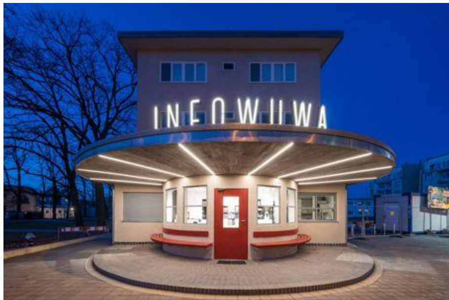
Fot. 28 Odnowiona elewacja Źródło: fot. Maciej Lulko dla archinea.pl, dostęp: 24.04.2021
